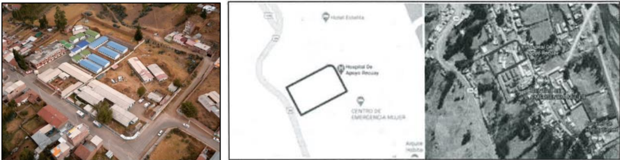
Vista del terreno para la construcción de Hospital Apoyo Recuay
